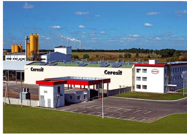
Завод по производству сухих строительных смесей, г. Балаклея.
